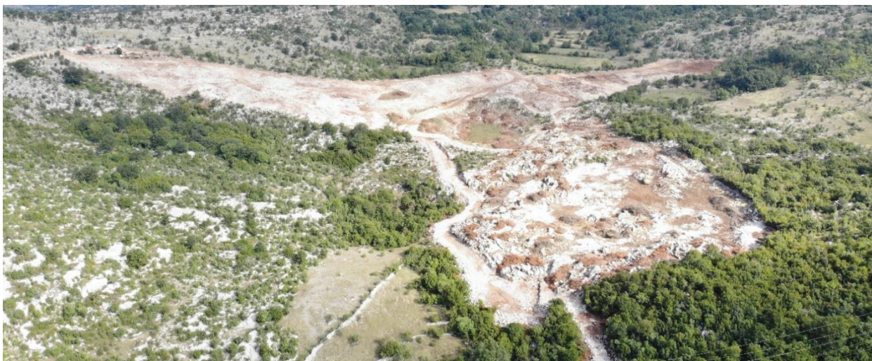
Slika 4: Zahvat solarne elektrane nakon završenih pripremnih radova
