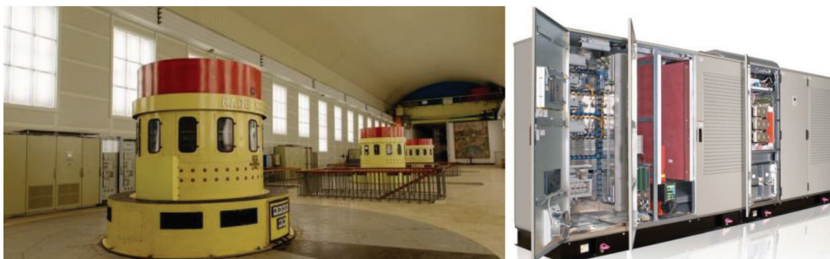
Slika 12. Izgled sinhronog generatora i njegovog pobudnog sistema u HE „Piva“
