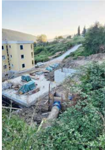
Izgled gradilišta sa cjevovodom, foto: O. Doklešić
