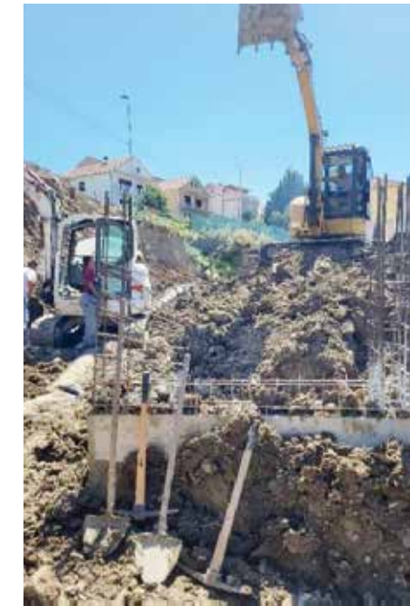
Radovi na iskopavanju cjevovoda, foto: O. Doklešić
