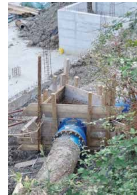
Izgled zašalovanog anker bloka, foto: O. Doklešić
