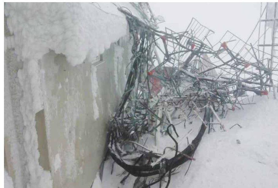
Do danas nije demontirana čelična konstrukcija sa lica mjesta, foto: rtcg.me
