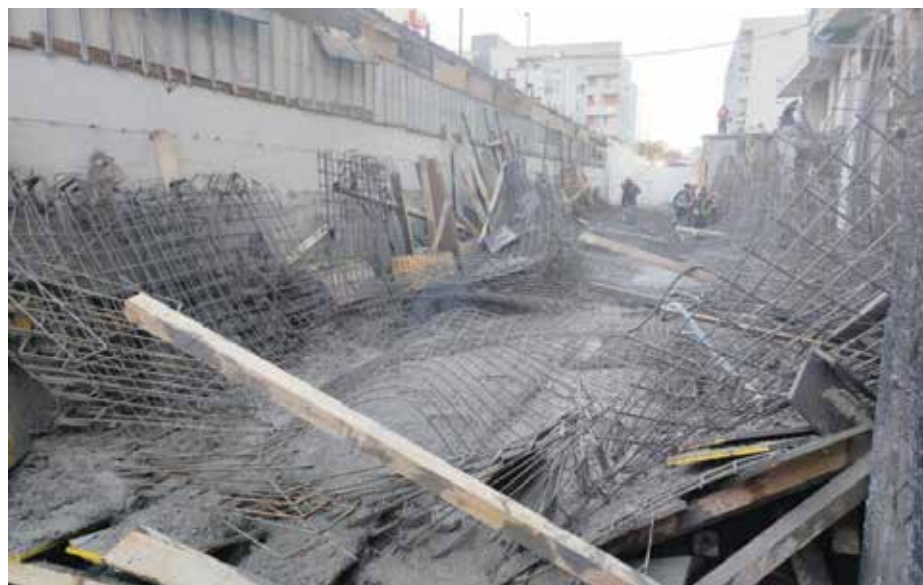
Rušenje armirano-betonske ploče na zgradi u Golubovcima, foto: Pogled.me
