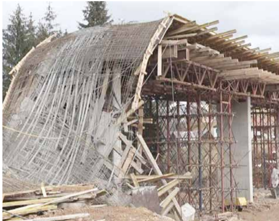
Rušenje mosta u izgradnji u Rožajama, foto: Svetlana Četković
