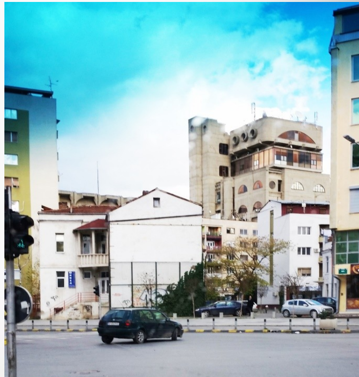
Onemogućen pristup za protivpožarno vozilo
