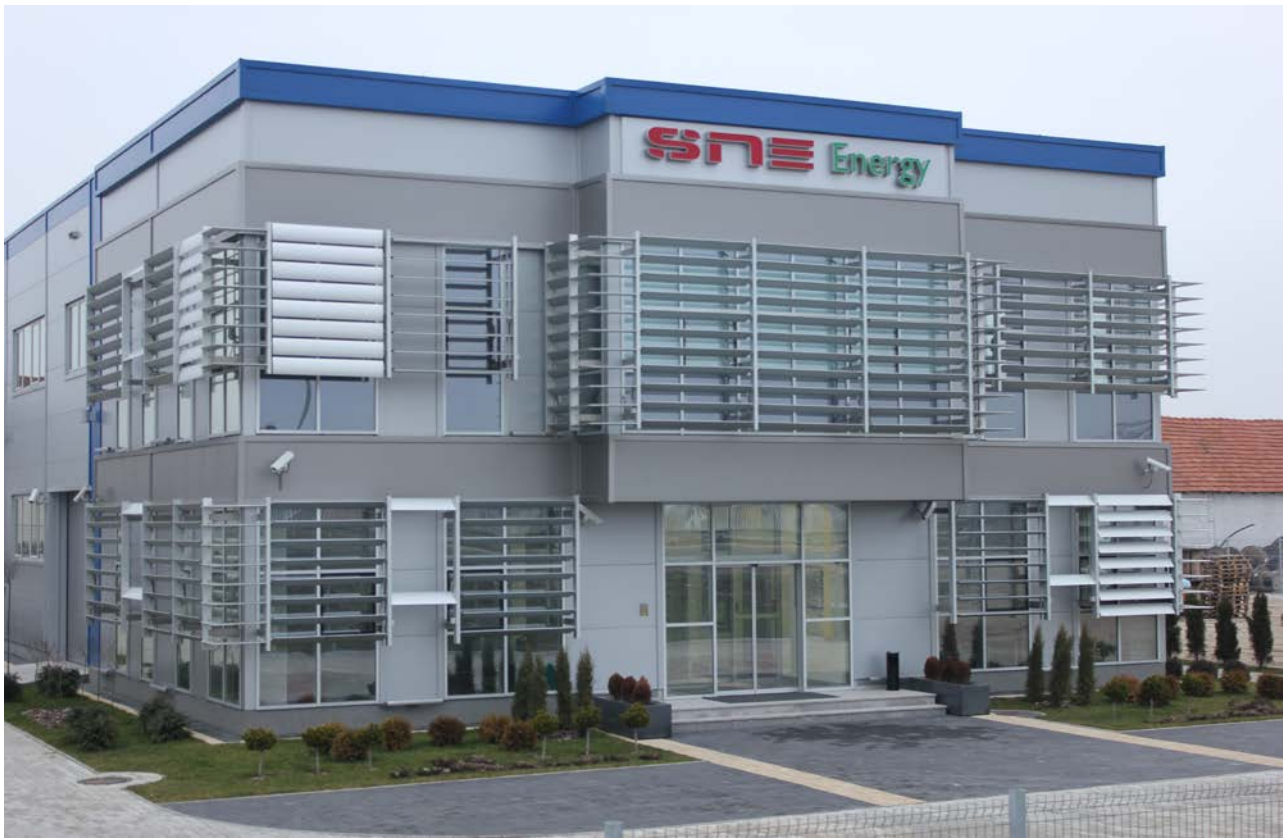
Fotografija broj 4 Izgled objekta sa spoljašnjim Al brisolejima na elektromotorni pogon za zaštitu južne i jugozapadne fasade od insolacije
