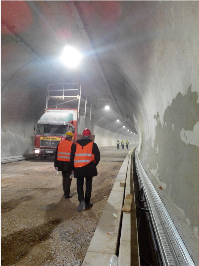
Slika 17 - Kablovski regali u tunelu u fazi izvođenja
