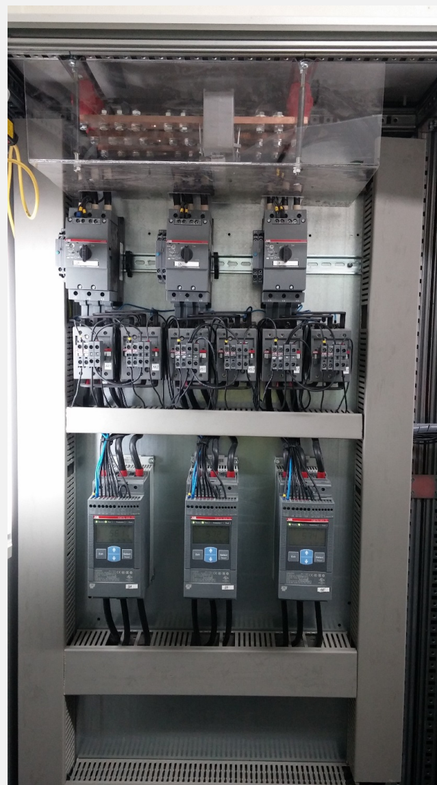
Slika 23 – Izgled komandnog i razvodnog ormara ventilacije (KOV/ROV)
