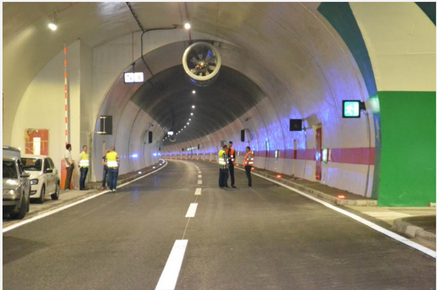
Slika 31 – Tunelski ventilator
