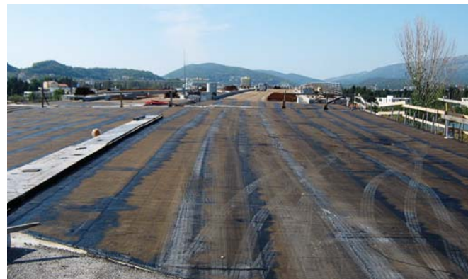
Port Milena izgradnja mosta
