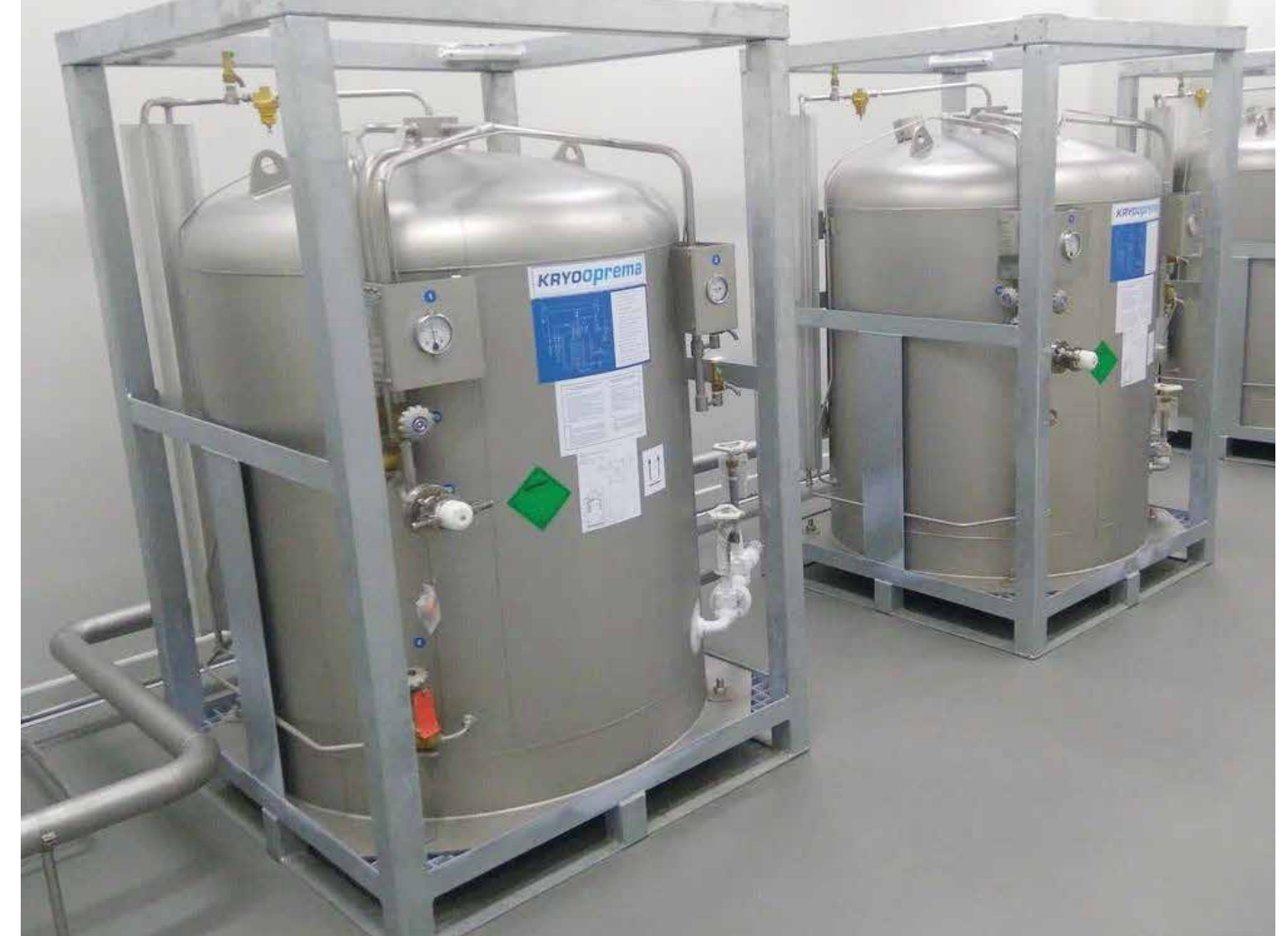
Ilustracija 7: Dvije kriogene posude od po 1000l - pomoćni objekat, foto: kryooprema.com
