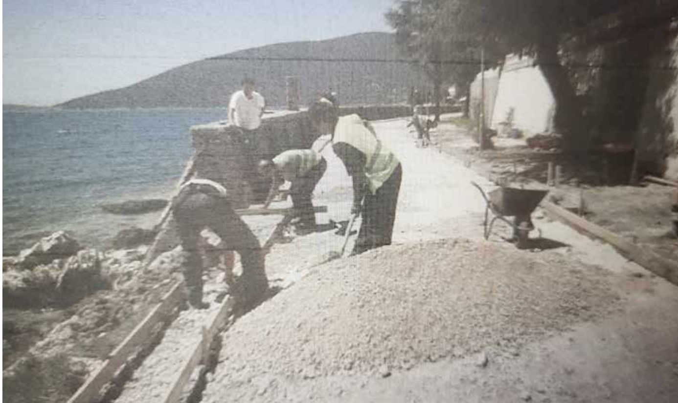
Radovi na kolektoru kanalizacije, 2012, foto: O. Doklešić
