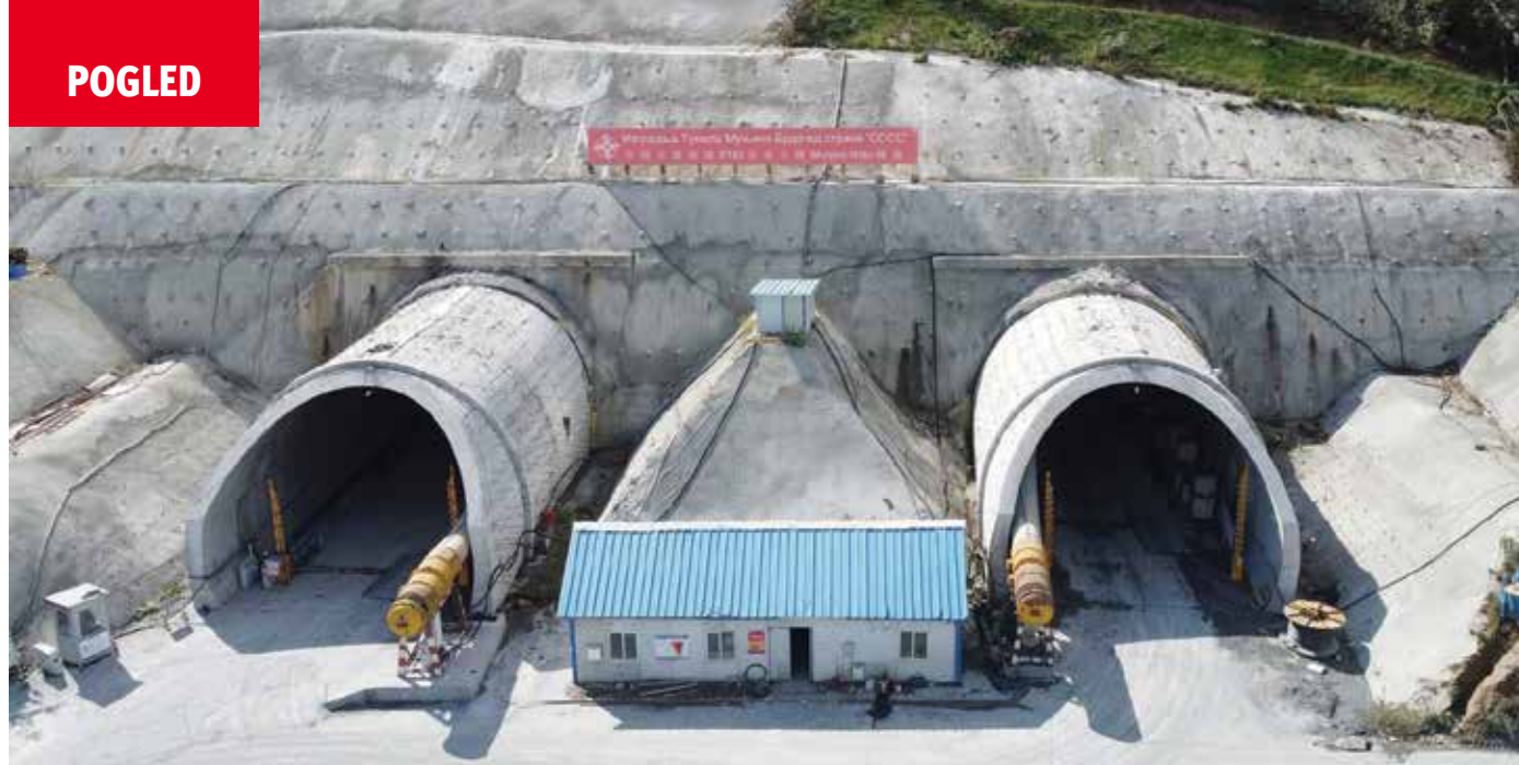
Probijen najduži tunel prema Crnoj Gori – „Munjino brdo“ spaja dionicu od 150km, foto: gradnja.rs
