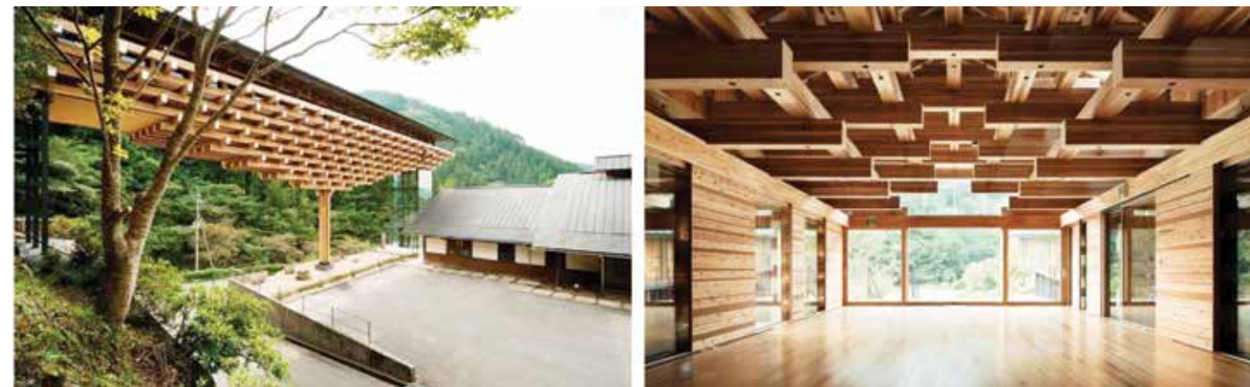
Muzej drvenog mosta u Jusuhari: a) Most između muzejskih zgrada b) Plafon jedne od muzejskih zgrada, foto: architecture-tokyo.com
