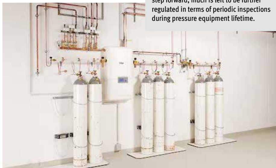
Ilustracija 2: Gasna podstanica - jeste objekat ili dio objekta, foto: draeger.com
