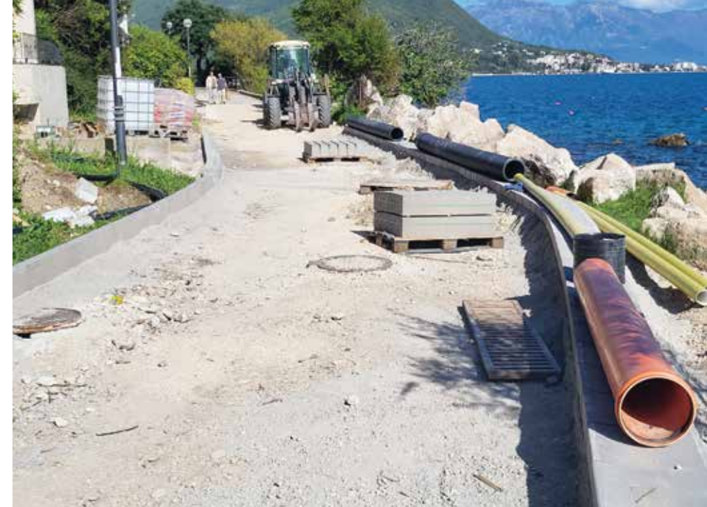
Radovi na šetalištu Pet Danica na Savini, april, 2025, foto: O. Doklešić
