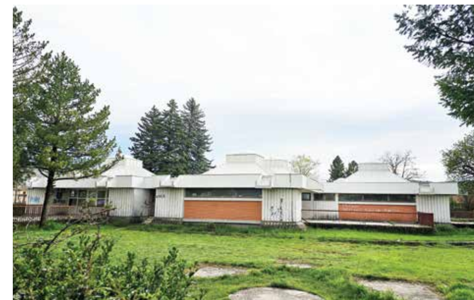
Pogled na sjevernu fasadu vrtića „Sunce“, foto: Privatna arhiva
