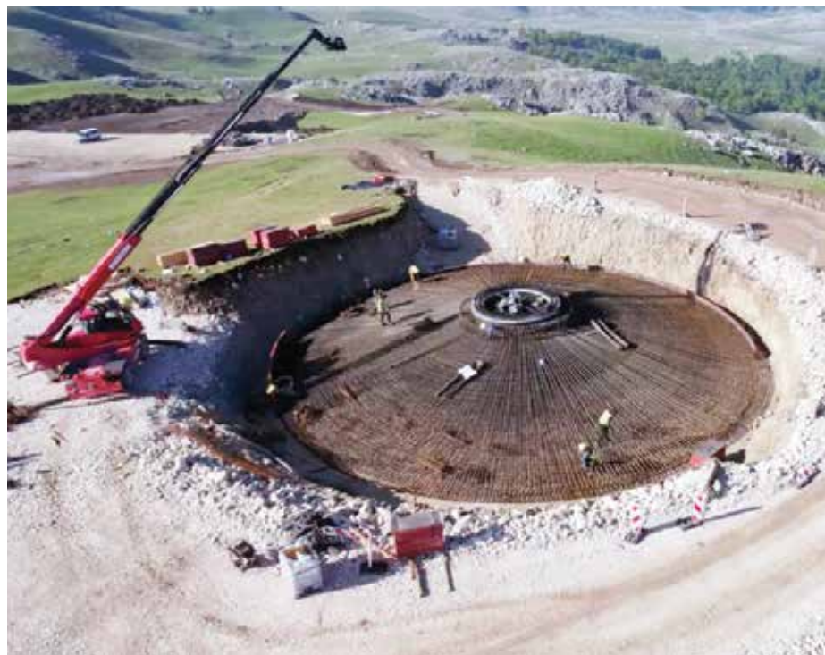
Radovi na vjetroelektrani Gvozđ, foto: Bemax/You Tube
