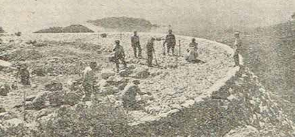
Izgradnja puta Cetinje-Budva, foto: monenegrina.net
