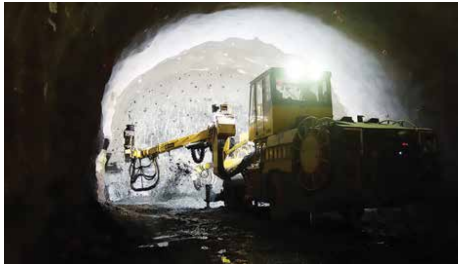
Faza bušenja i miniranja duboko ispod Boknafjorda pomoću specijalizovanih „džambo” mašina, foto: Øyvind Ellingsen / Statens Vegvesen
