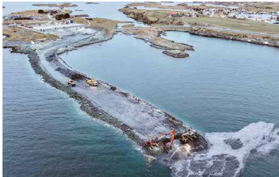
Izgled gradilišta sa spoljašnje strane, na mjestu gdje trasa auto-puta E39 ponire u podvodni greben. Sa ove pozicije dvocijevni drumski tunel Rogfast započinje svoje zaranjanje ka rekordnoj dubini od 390 metara ispod nivoa mora, foto: : Øyvind Ellingsen / Statens Vegvesen
