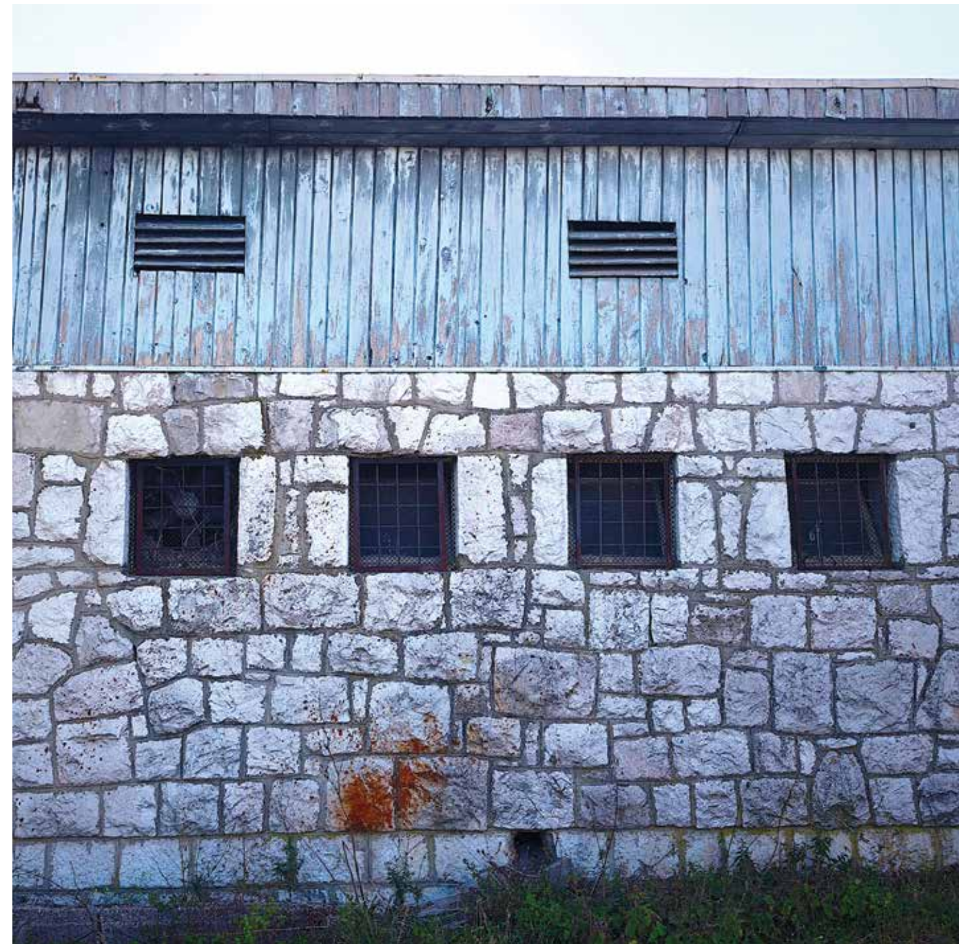
Prikaz otvora na stacionarnom dijelu objekta, 2026, foto: Privatna arhiva autora
