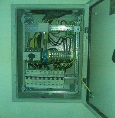
U razvodnom ormanu ne postoji zaštitna elektroizolaciona pregrada koja sprečava direktni dodir delova električne instalacije pod naponom (uobičajene su pregrade izrađene od pleksiglasa, pertinaksa ili plastike)
