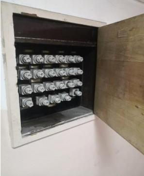
Razvodni ormani izrađeni od zapaljivog materijala – drveta, iako važeći tehnički propisi zahtevaju da razvodni ormani budu izrađeni od metala – dva puta dekapiranog lima
