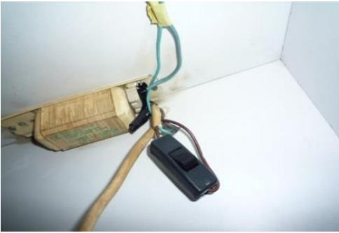
Nepropisno izvedeni delovi električnih instalacija najčešće mogu na potencijalno loše izvedenim električnim vezama (kontaktima) da izazovu početni požar [9,10] ili da se usled instalacije provodnika smanjenog poprečnog preseka desi preopterećenje strujnog kola
